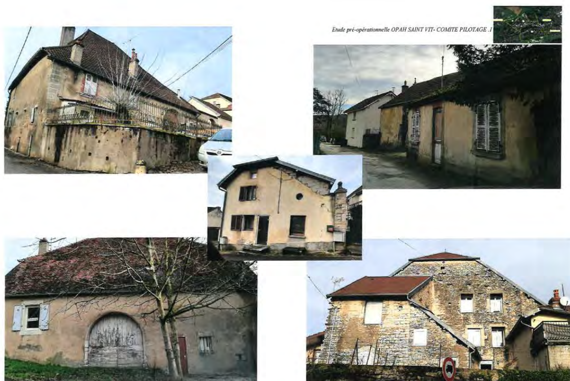
Façades de Saint Vit, source : comité de pilotage étude pré opérationnelle OPAH
